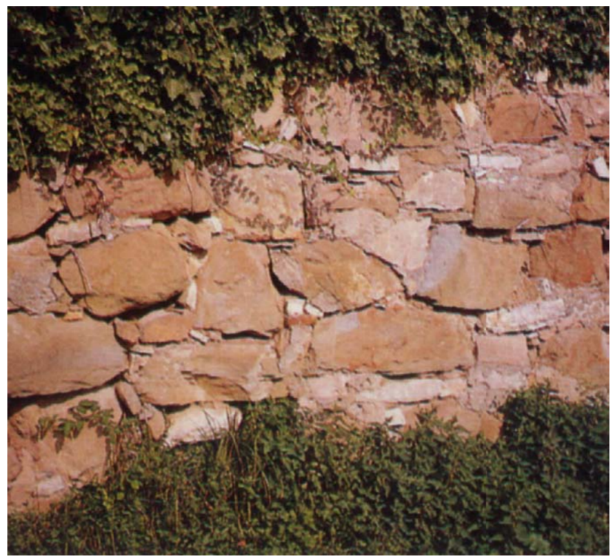
Muro a secco con arenaria di Sarnico*
