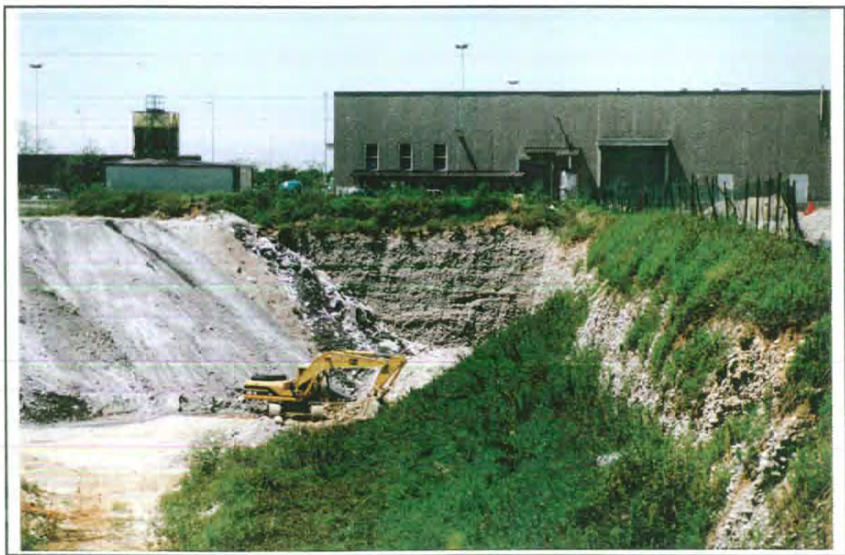
Foto 18. Discarica di inerti in località P.I.P. L'ex cava di ghiaia appare già in avanzata fase di colmamento.
