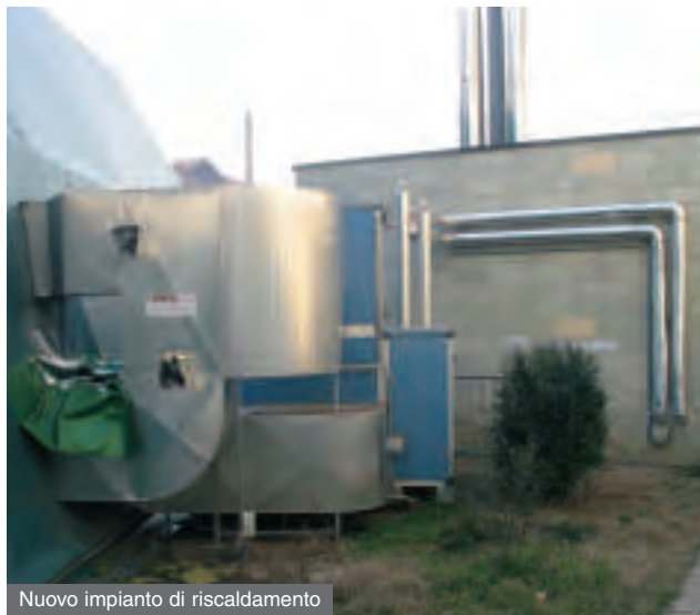
Nuovo impianto di riscaldamento
