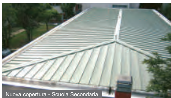
Nuova copertura - Scuola Secondaria
